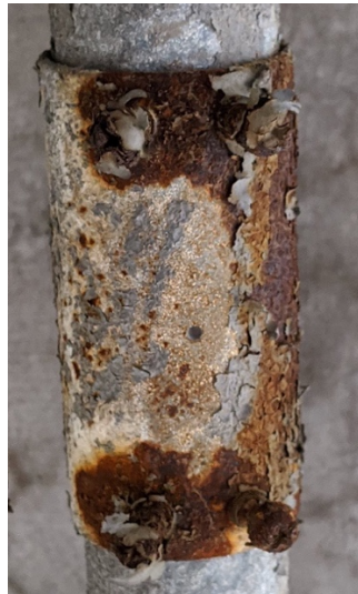
図 4.1 腐食画像の例
